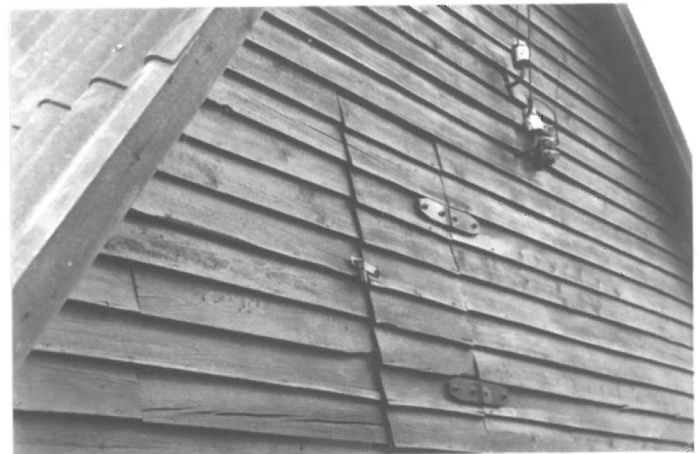
Tingstedvej 15, brædder som klinklægning i gavl.
