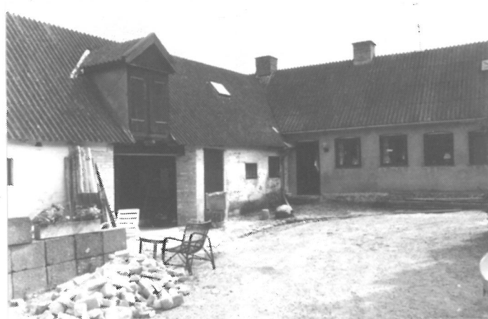
Sømosevej 2. Staldlænger under ombygning på Søgård
