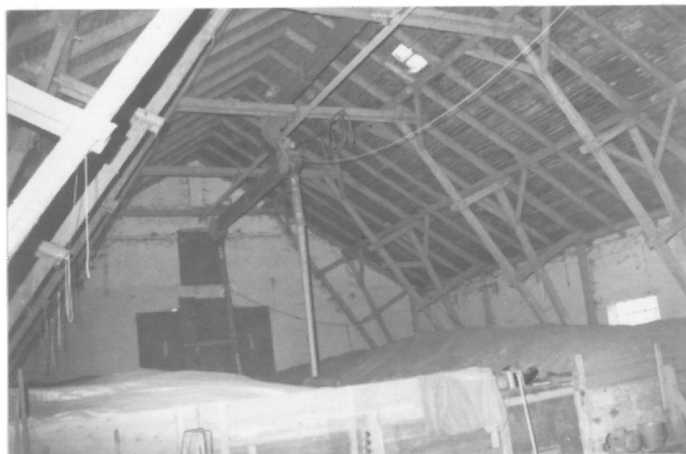
Thorsbrovej 13, spændende sulekonstruktion på Lundhøjgård.
