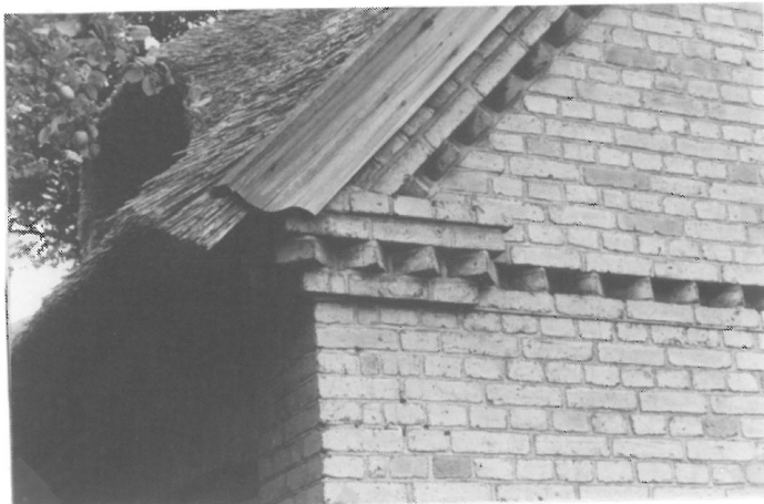
Tingstedvej 8, savtaksgesims, gule mursten og stråtag
