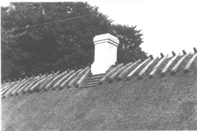
Thorsbrovej 11, Skorsten med muret krave til stråtag
