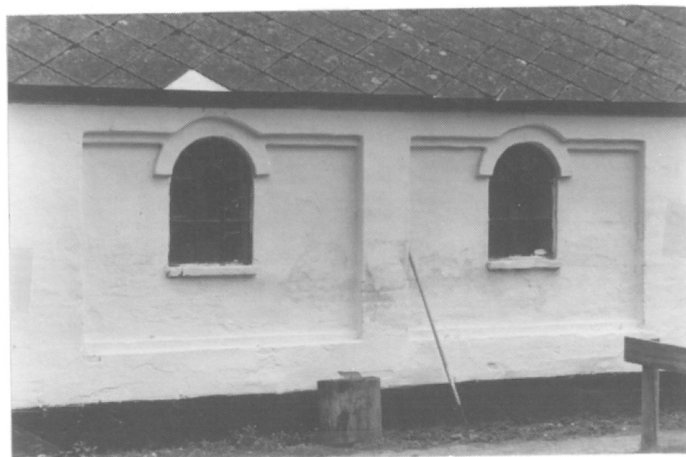
Thorsbrovej 8, buede staldvinduer Reerslevgård.
