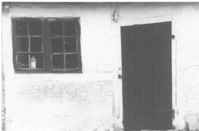
Thorsbrovej 11, sætninger optages
