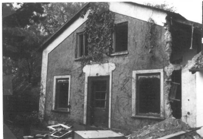
Thorsbrovej 3, under nedrivning. Pisehus opført ca. 1840.
